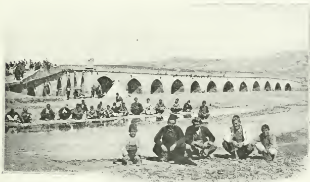
LE PONT DE MALAKIA, PRÈS SIVAS, SUR LE KIZIL.
